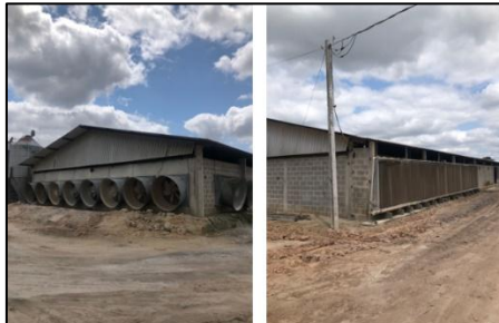
Figura 5. Exaustores e placas evaporativas.
